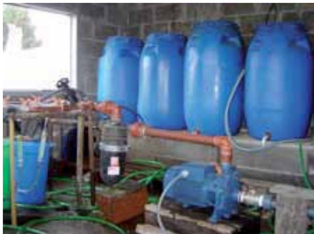
Figura 17. Sala de distribución de fertirriego con tanques de soluciones madre, bomba, filtros y los dos venturis en el vivero del Paider forestal, UNPSJB, Esquel, Chubut (Foto Enricci 2006).
