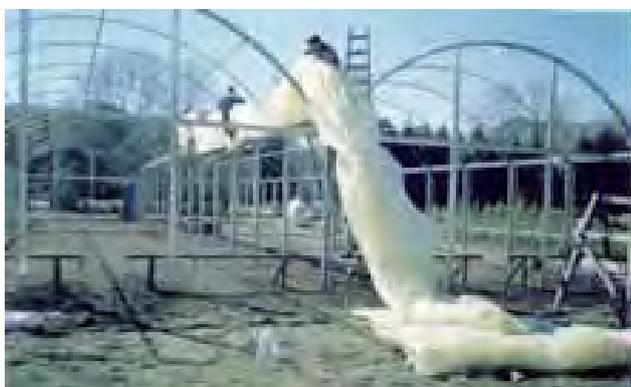
Figura 8. Instalación de cubierta plástica en el vivero Hua Hum, San Martín de los Andes, Neuquén (Foto Enricci 2003).
