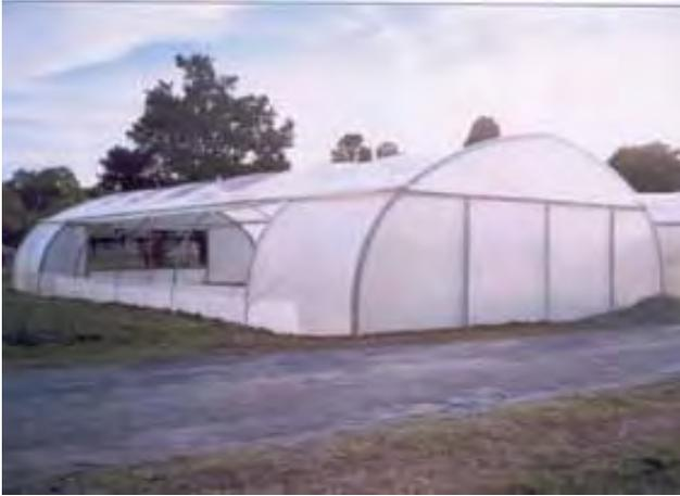
Figura 1. Invernáculo tipo túnel "ADC" con ventanas laterales.
