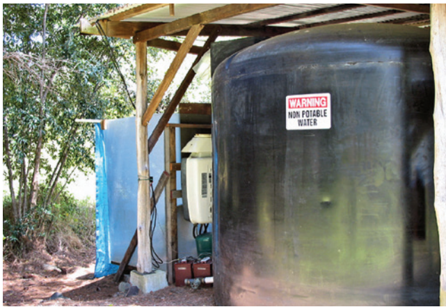
Figura 11.7 —Una inversión prudente es un tanque de almacenamiento de agua de reserva que contenga suficiente agua para satisfacer las necesidades del vivero durante al menos una semana. Foto de Thomas D. Landis.
