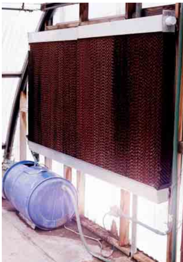
Figura 1.4.1. Los ambientes de propagación pueden ser enfriados reduciendo la luz solar mediante malla sombra (A), incrementando la circulación horizontal del aire con ventiladores (B) o con enfriamiento por evaporación mediante la circulación de aire a través de una pared húmeda (C).
