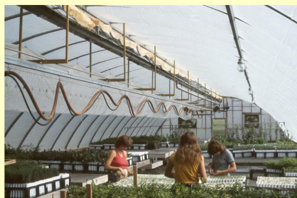
B Figura 3.1.27 Las unidades calentadoras son relativamente pequeñas y están localizadas en cada estructura de cultivo (A), donde éstas son colocadas para distribuir calor directamente al cultivo de plántulas (B).
