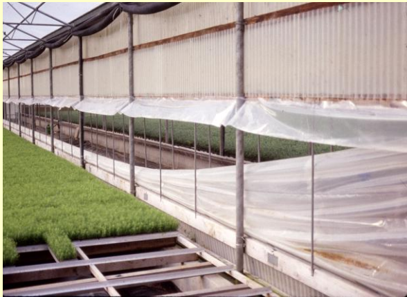
Figura 3.1.14 En los invernaderos con paredes de "Polyvent®" se pueden desinflar los paneles para generar una buena ventilación cruzada durante el tiempo atmosférico cálido. Durante el invierno, los lados pueden ser inflados para proporcionar un aislamiento cálido.
