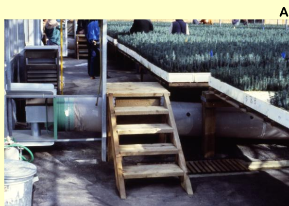
B Figura 3.1.27 Las unidades calentadoras son relativamente pequeñas y están localizadas en cada estructura de cultivo (A), donde éstas son colocadas para distribuir calor directamente al cultivo de plántulas (B).
